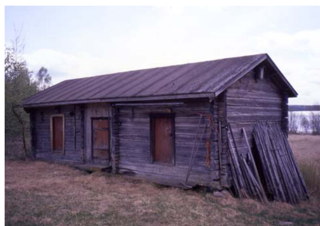
Kuva 4. Noin sata vuotta vanhat vilja-aitat ovat seutukunnalle tyypillistä hirsirakennustyyliä
